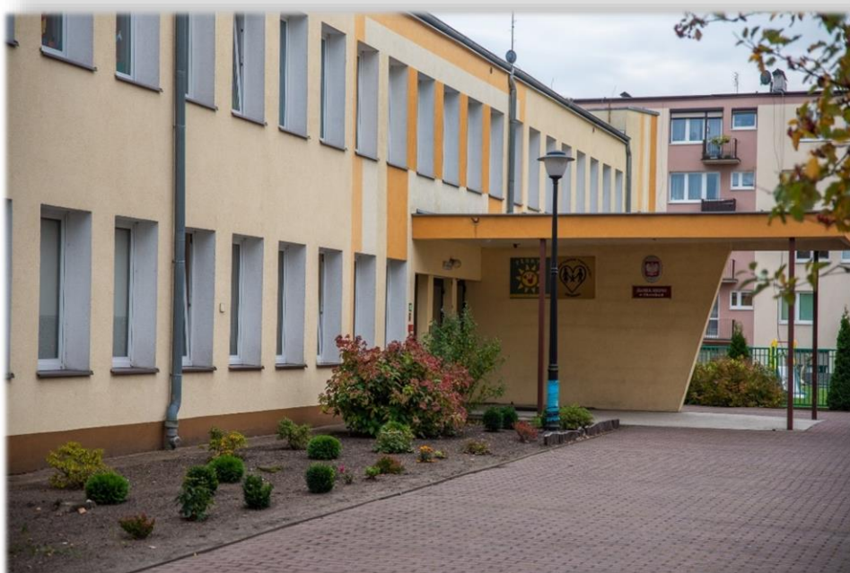
Budynek Żłobka Miejskiego w Obornikach
