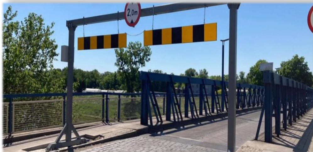
Bramownica na moście w ciągu ul. Armii Poznań
